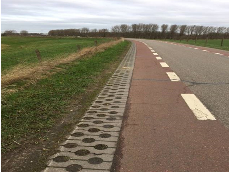
Figuur 1: Illustratie toepassing grasbetontegel (NB: belijning en kleuren niet representatief voor dijktraject)
