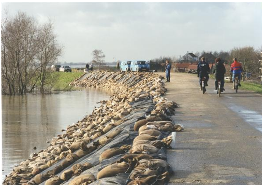
Figuur 1-1: De dijk bij Ochten met noodreparaties, tijdens hoogwater in 1995 (bron: beeldbank RWS).
