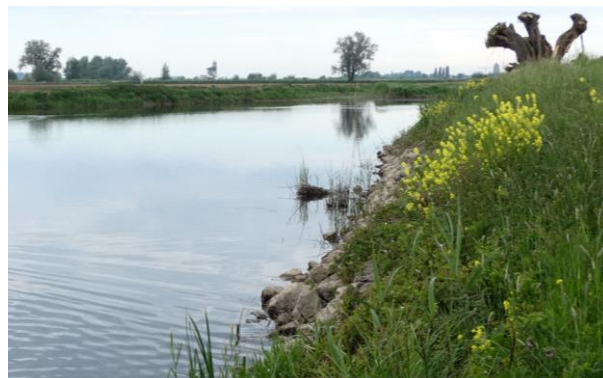
Foto 2-8. Steenbestorting langs steile oever om bevers te weren
