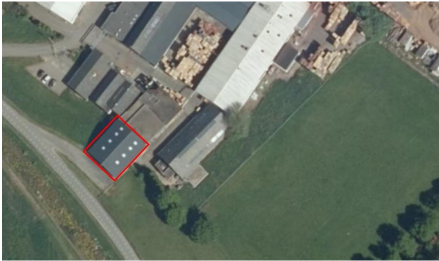
Figuur 2-2 Te slopen loods aan de Waalbandijk 115 (roodomlijnd)
