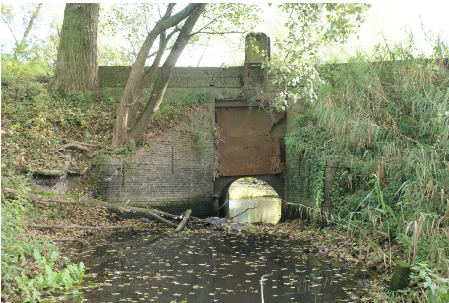
Foto 4 Kunstwerk ter hoogte van bestaande toegangsweg.
