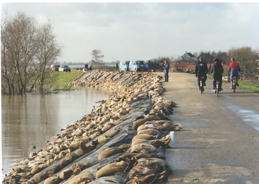
Figuur 1.1: De dijk bij Ochten met noodreparaties, tijdens extreem hoogwater in de Waal in 1995 (bron: beeldbank RWS).
