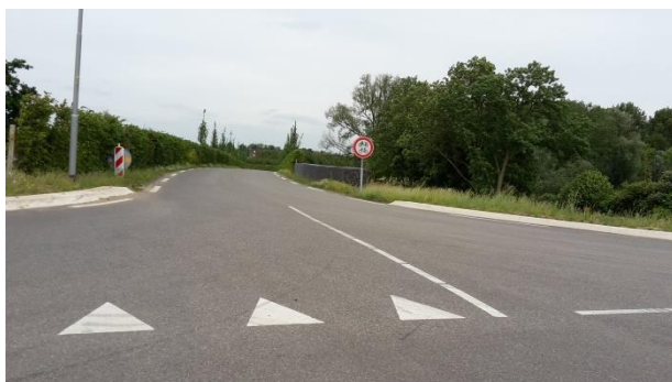
Foto aansluiting Waalbandijk met Dodewaardsestraat
