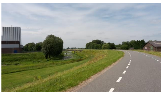
Foto Waalbandijk met links zicht op centrale
