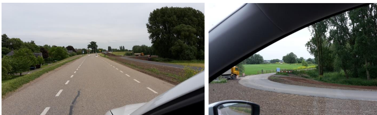
Foto's verbindingsweg grondstoffenbedrijf in aanleg
